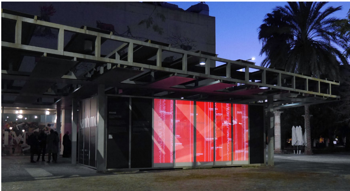
Exterior de la instalación MENT – MuVIM
